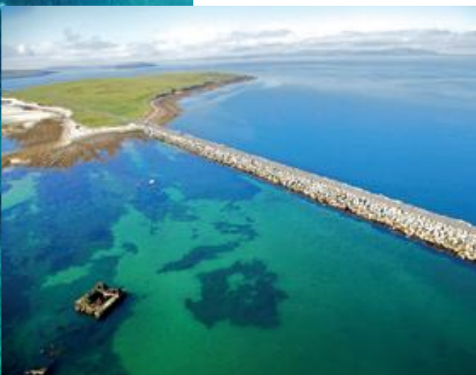
Churchill Barrier als afsluiting van Scapa Flow, aangelegd door Italiaanse krijgsgevangenen.
